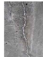
バクテリアの代謝活動による ひび割れ修復状況
